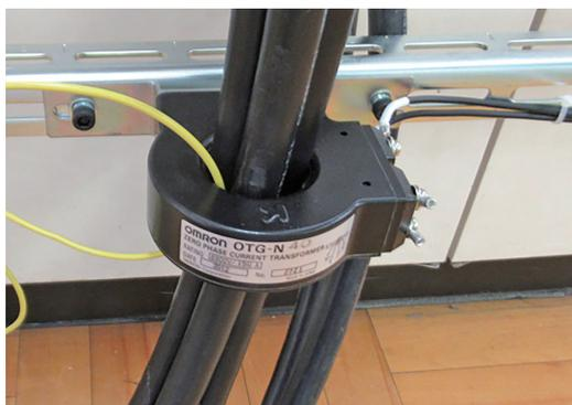
図10 別電源による模擬地絡電流の発生
