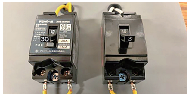
図4 配線用遮断器と漏電遮断器
