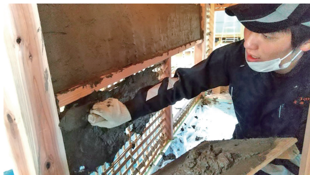
土壁塗り作業（荒壁塗り）
