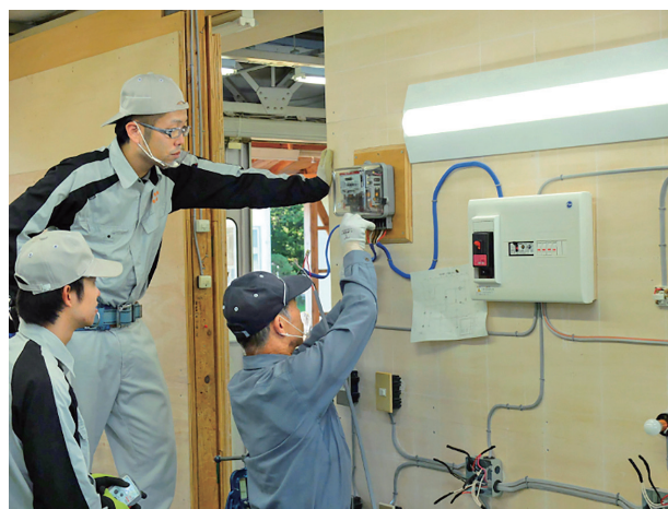
電気工事実習
