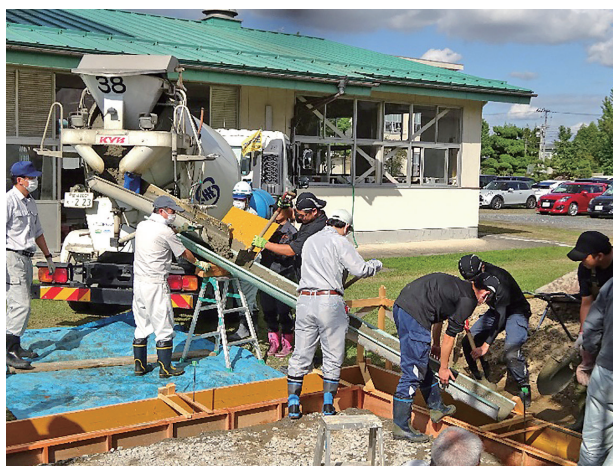
コンクリート基礎工事
