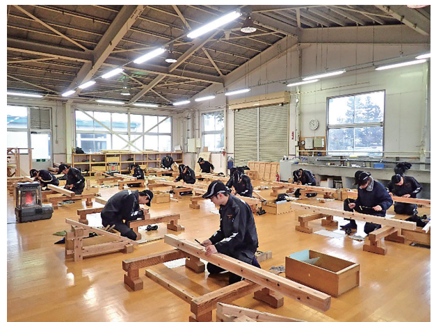
継手・仕口製作
