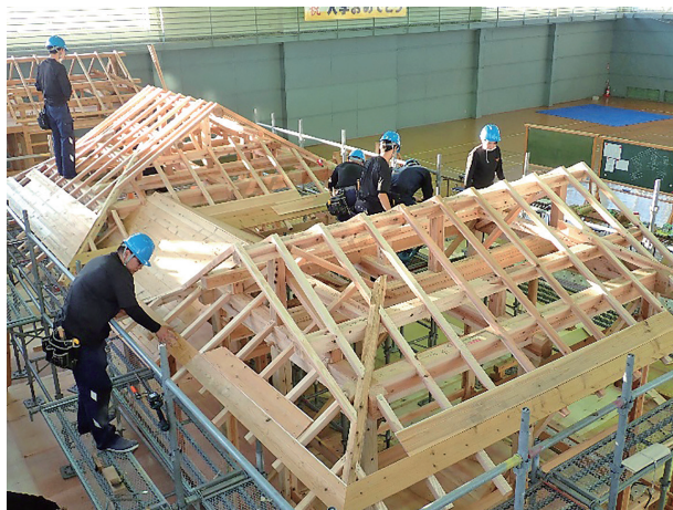
茶室の入母屋根施工
