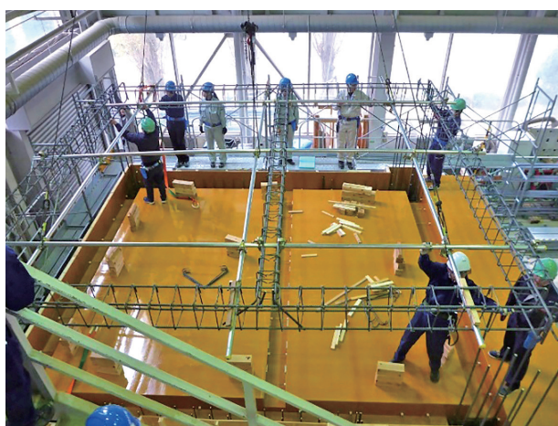
図8 梁鉄筋の先組み工法
