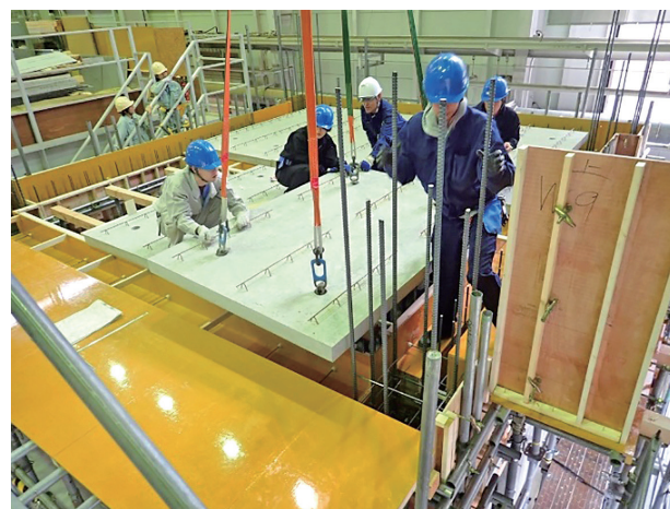
図9 スラブ型枠のハーフPCa板
