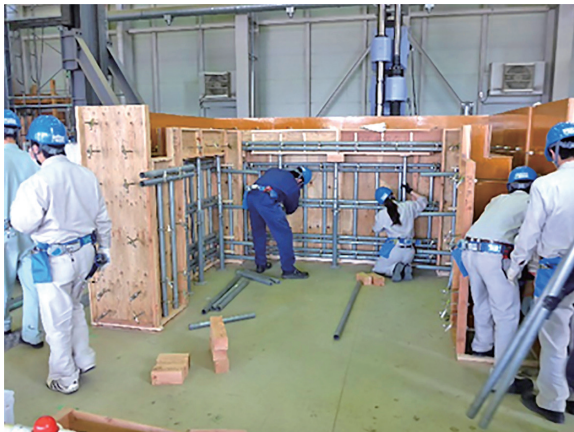
図2 II期の標準課題実習の型枠工事 平成29年度
