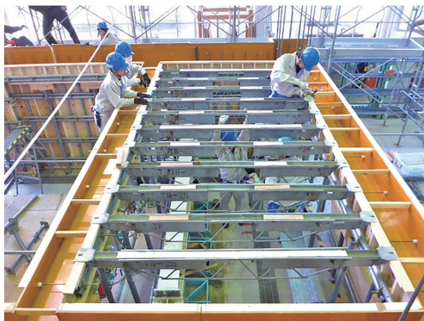
図7 型枠支保工での支保梁工法
