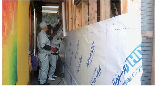
図12 外壁下地取付(防風シート張)状況
