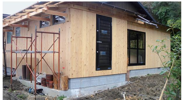
図14 外壁張り工事状況(南西より撮影)
