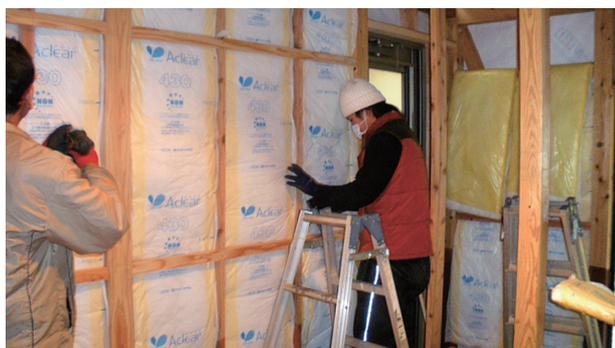
図18 断熱材充填及び内壁下地工事状況
