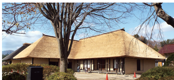
2014年屋根葺き替え完成 国指定重要文化財菊池家住宅（遠野伝承園）
