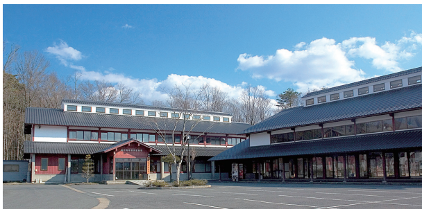
認定訓練校では国内初の木造校舎（H9年建築）
