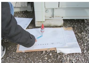
写真10 仮設住宅（千葉県旭市） 真北測定
