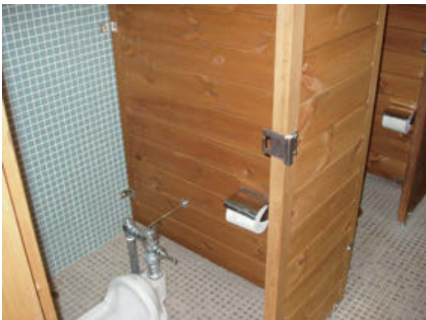
図12 完成したトイレブース
