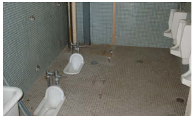
図5 既存ブース撤去後
