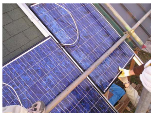
写真6 太陽光発電パネル取り付け工事
