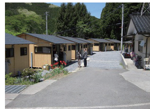
住田町の木造仮設住宅 (2001/5、全国に先駆けて建設)
