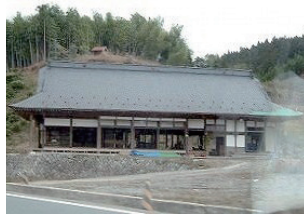
矢作町の民家 (矢作町、浸水)
