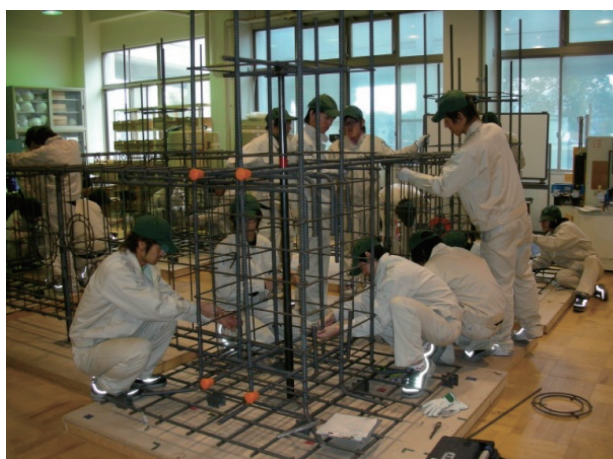
RC施工実習
