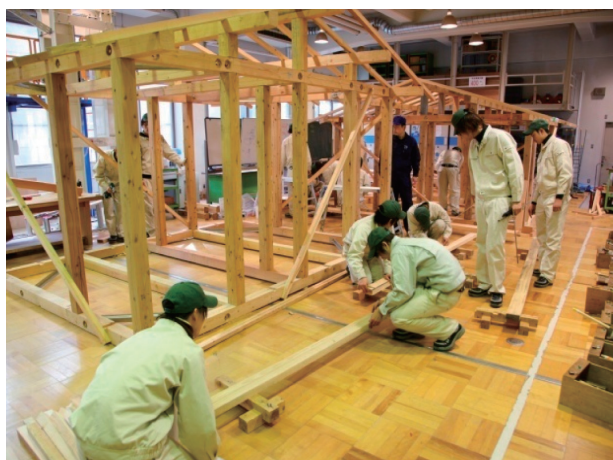
木造施工実習
