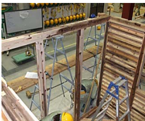
写真14 梁の取り付け
