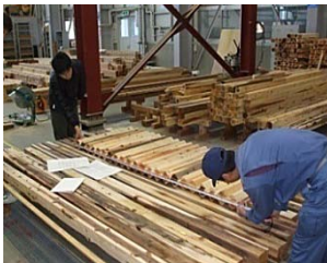
写真22 壁高さの確認
