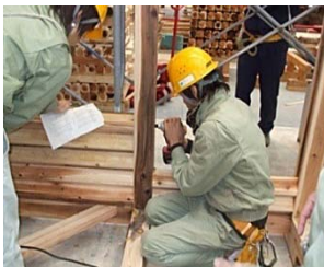
写真12 コーチスクリューの取り付け
