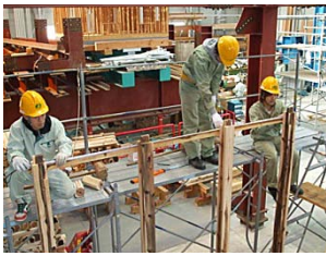
写真20 頭つなぎ取り付け
