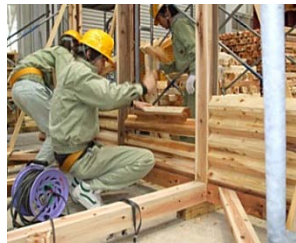
写真11 壁材の取り付け
