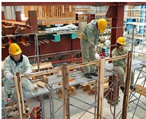
写真10 柱の頭繋り取り付け
