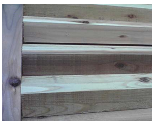
写真24 壁の隙間
