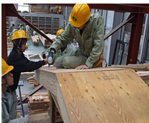
写真16 野地板の取り付け
