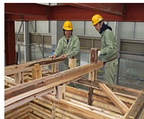
写真15 母屋・棟の取り付け
