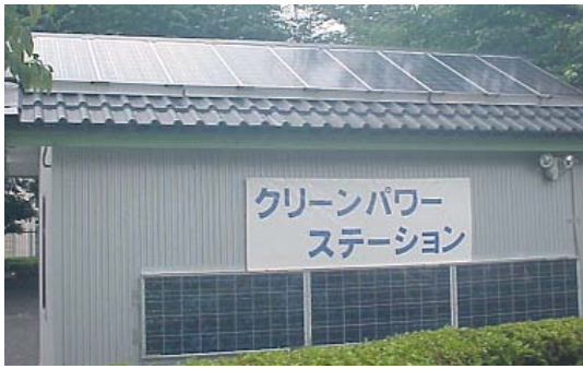
図8 職業大東京校での敷設状況
