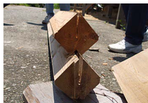
写真6 ログ材の形状と重ね方
