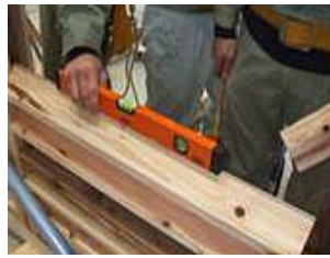
写真21 水準器でのレベル確認
