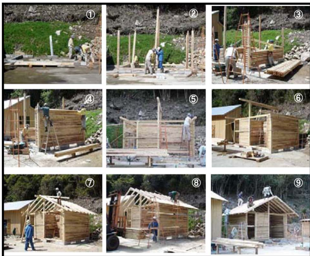
写真4 ログハウス施工手順
