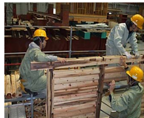
写真13 桁の取り付け
