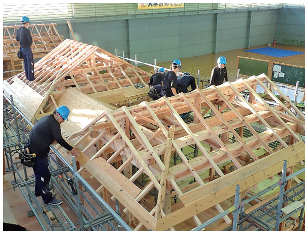
茶室の入母屋根施工
