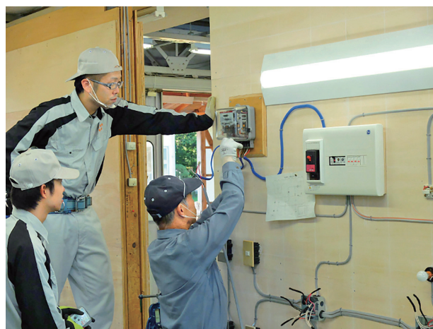
電気工事実習
