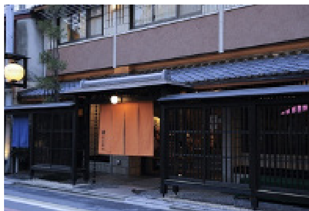
図3 綿善旅館外観
