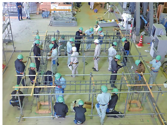
図1 Ⅱ期の標準課題実習の鉄筋工事 平成29年度
