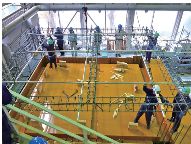
図8 梁鉄筋の先組み工法
