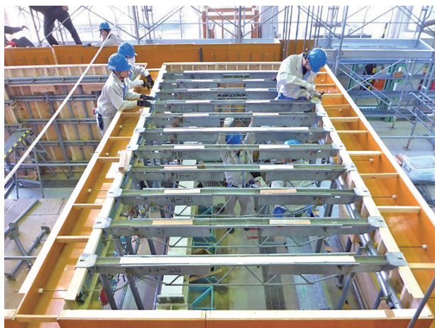
図7 型枠支保工での支保梁工法
