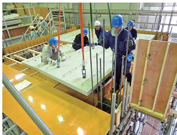
図9 スラブ型枠のハーフPCa板
