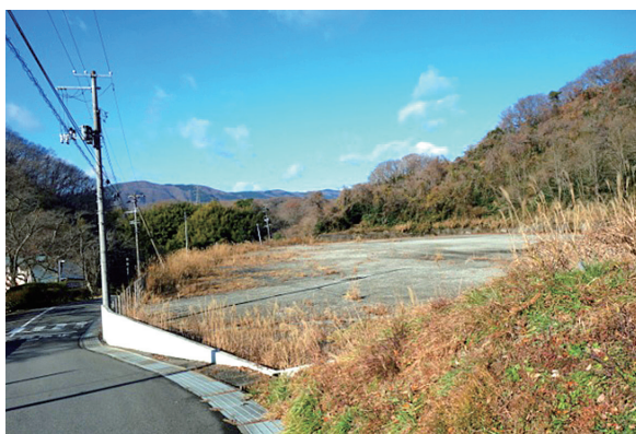
写真10 地震により使用不能となった本館及び実習場が取り壊され市に返還される敷地
