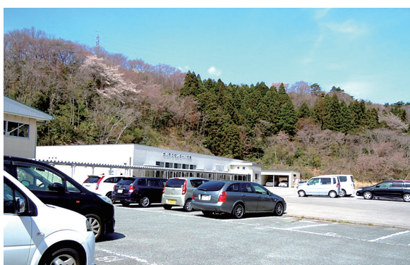
写真11 旧グラウンドに新たにコンパクトに設置された本館棟の外観
