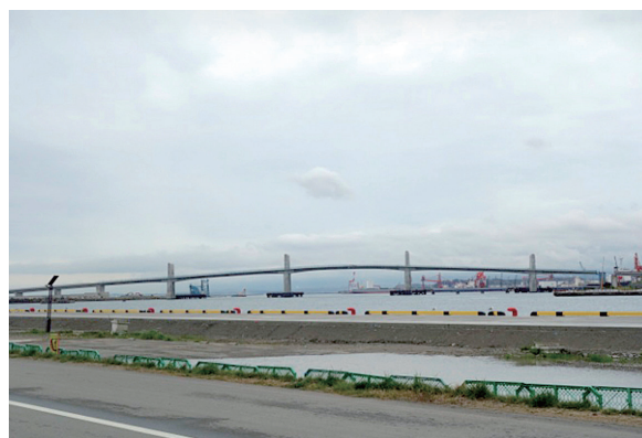
写真9 小名浜港の港湾整備（石炭荷揚げのための人口島と3号ふ頭を結ぶ橋梁工事）
