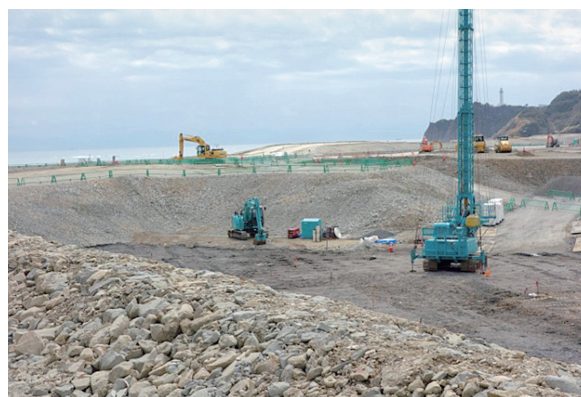
写真3 薄磯地区の整備工事の状況
