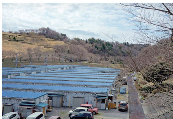
写真6 原発事故避難者の仮設住宅（その1）
