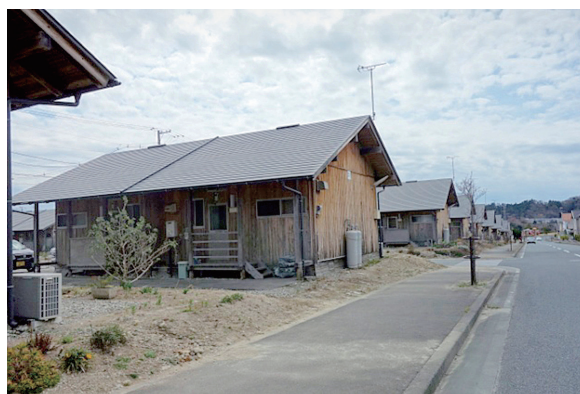
写真7 原発事故避難者の仮設住宅（その2）
