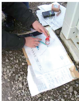
写真10：建屋軸線計測作業
