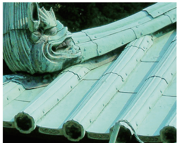
徳川義直公廟（定光寺）：丸形瓦棒キャップ・ドブ板の継手にはハゼ加工は見られない
