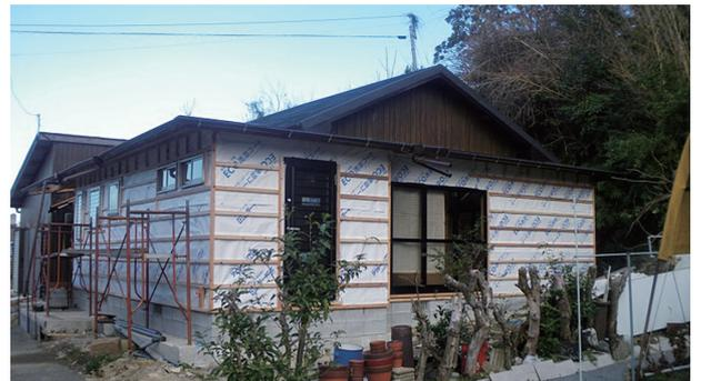
図13 外壁下地取付工事状況(南西より撮影)
