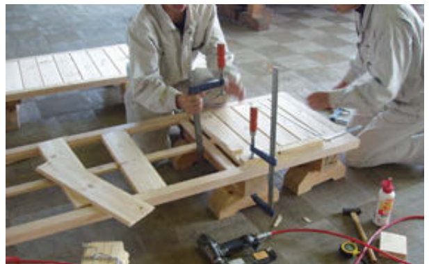
図8 鏡板の取付け作業
