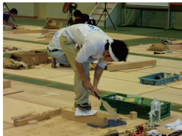
競技大会の状況（建築大工）
