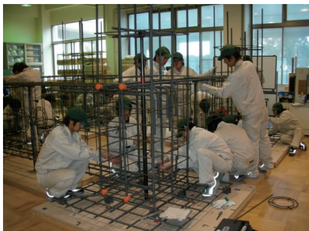
RC施工実習
