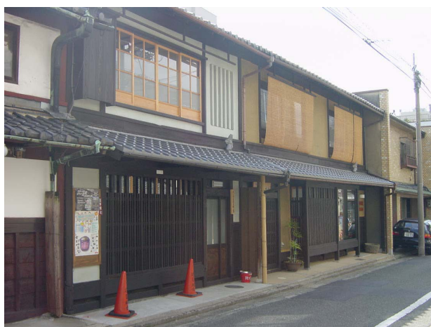
図3 大正時代の町屋 修復と耐震改修
