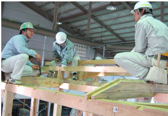
木造建築施工実習 (模擬棟製作)
