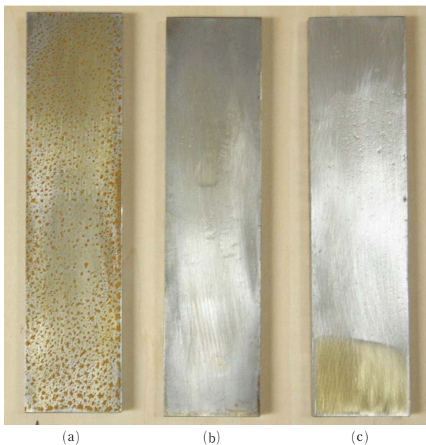
図9 型枠の腐食状況
