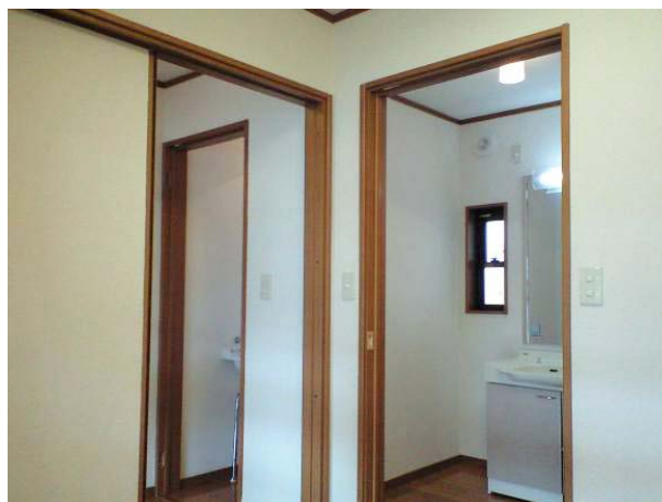
写真14 照明器具、スイッチ取付
