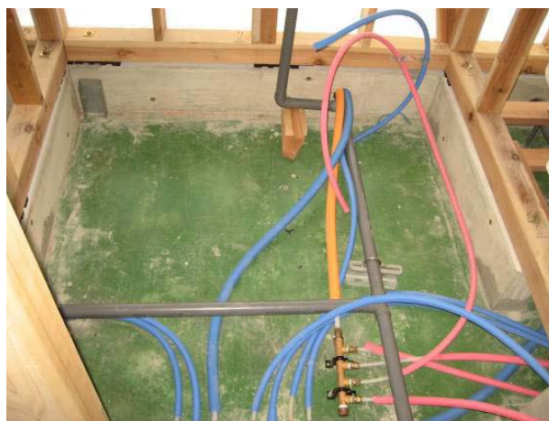
写真4 洗面所床下配管施工
