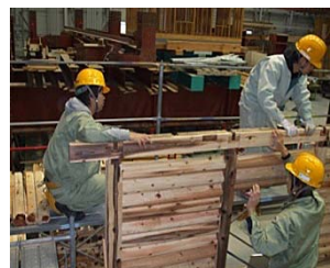
写真13 桁の取り付け
