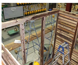
写真14 梁の取り付け
