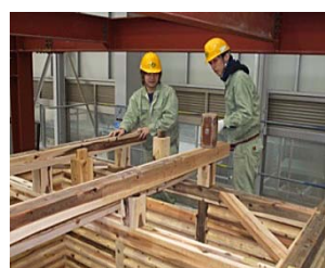
写真15 母屋・棟の取り付け
