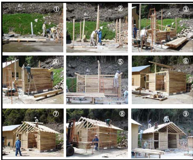
写真4 ログハウス施工手順
