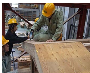
写真16 野地板の取り付け
