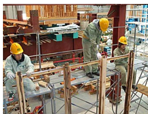
写真20 頭つなぎ取り付け
