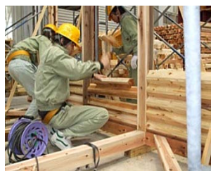
写真11 壁材の取り付け
