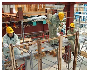
写真10 柱の頭繋取り付け
