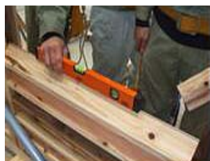
写真21 水準器でのレベル確認
