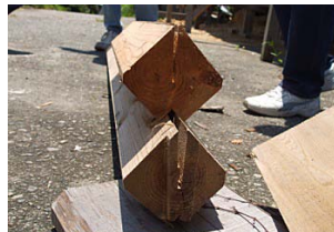
写真6 ログ材の形状と重ね方
