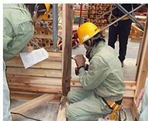
写真12 コーチスクリューの取り付け
