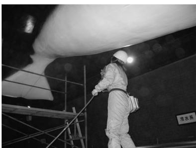
図17 ミンククジラ難燃剤吹き付け作業
