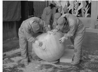
図3 スタイロフォームによる形状切り出し作業
