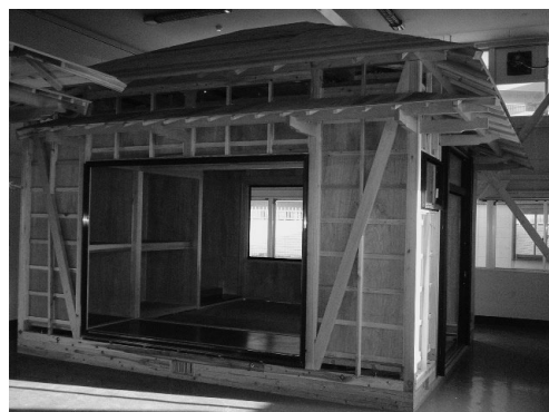
写真2 寄棟屋根の家
