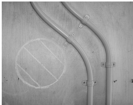
図5.2 障害物をかわす配管②
