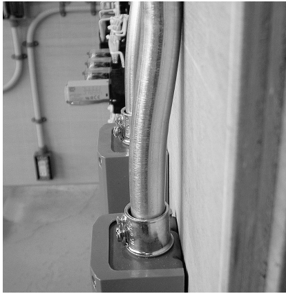
図2 金属管のS曲げ
