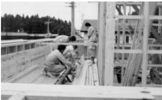
写真7 無落雪樋設置施工作業
