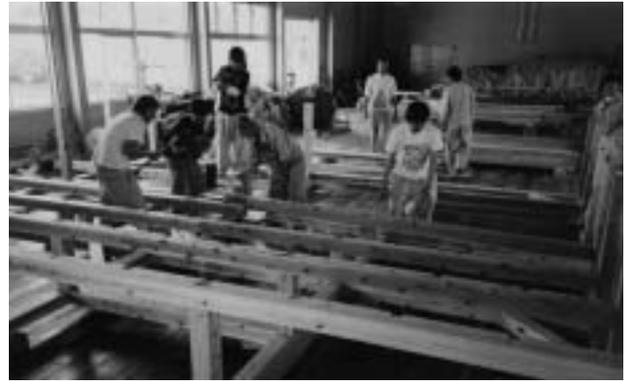
写真4 各構造材仮組み作業
