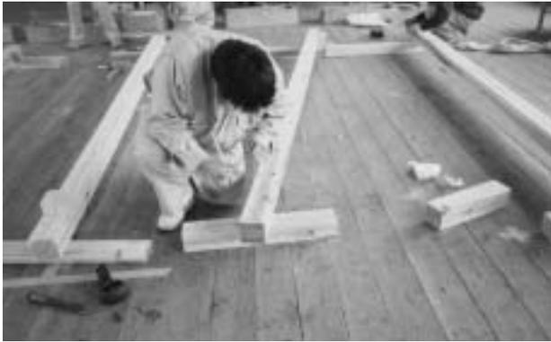
写真3 構造材墨付け・加工作業
