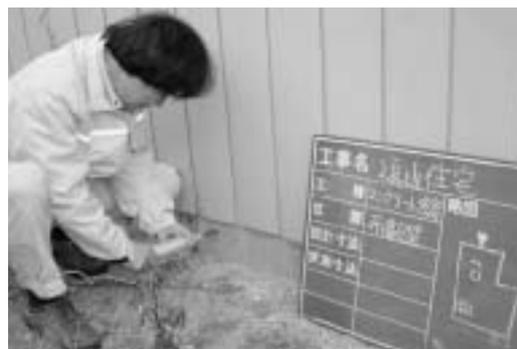
図2 基礎調査の様子（コンクリート強度調査）
