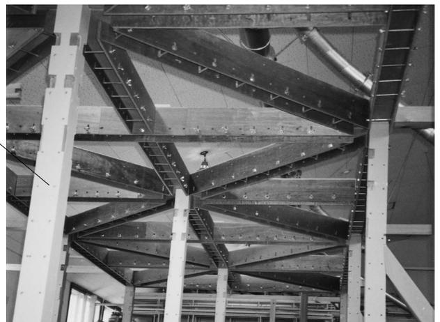
図3 上材に内部移動柱を取り付けた状態
