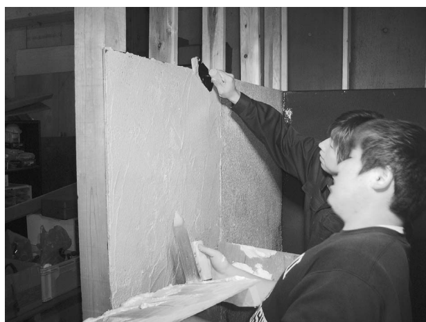
○これは、総合制作実習課題の一環で、健康に配慮した内壁仕上げ材の珪藻土の左官実習である。実学融合の学びには、やはり実習は欠かせない必須要素である。
