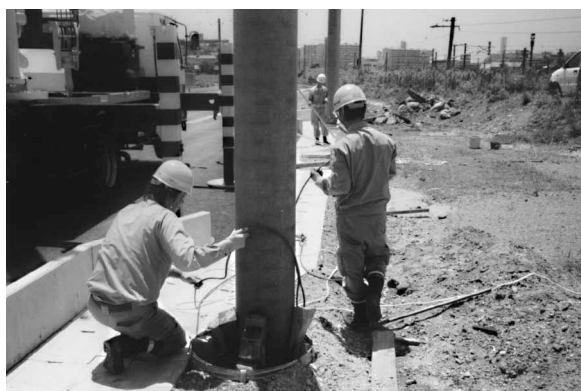
写真8 電車線路施工訓練（電車線柱建植）
