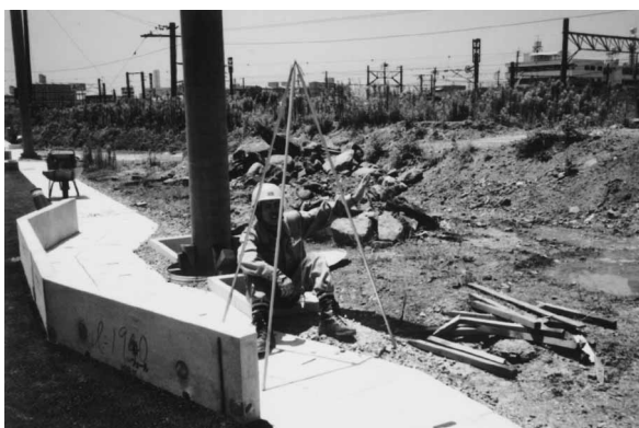
写真9 電車線路施工訓練（電車線柱偏位測定調整訓練）
