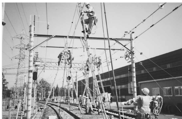
写真4 電車線路取付訓練（初級電気技術教育）
