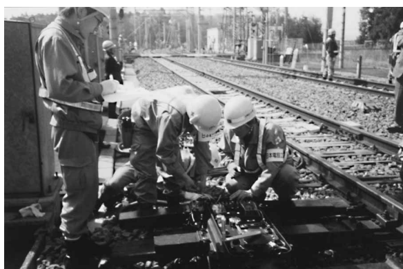
写真5 電気転てつ機取付訓練（初級電気技術教育）
